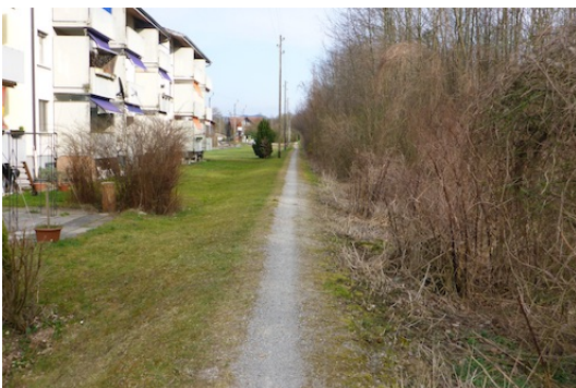
Hochwasserschutzdamm in Neuenegg (Foto Flussbau AG SAH)
