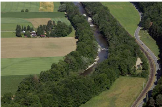
Linkskurve bei Widenrain. Blick in Fliessrichtung. (Foto Flussbau AG SAH)
