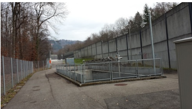
Schlammsammler Neuenegg (Foto: Joseph Brügger)
