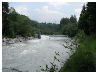
1 BKW-Fassung Hondrich mit Fisch- aufstieg auf der linken Bildseite.
