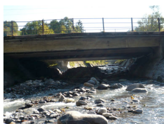
1 Ablagerungen in der Suld unter der Brücke BLS.
