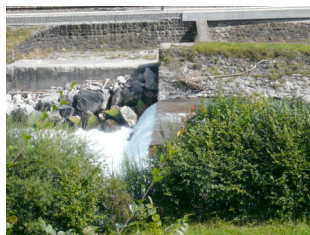
1 Betonschwelle auf der Höhe Mülönen (Nr. Q24, km 11.41) mit einer Höhe von grösser 70 cm
