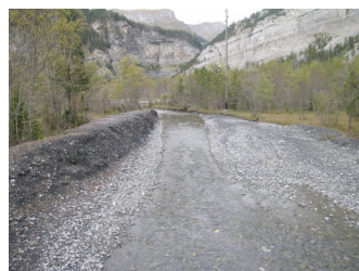
2 Gewässerunterhalt im Gasteretal mit linksseitiger Damm- schüttung
