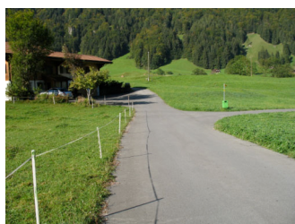
2 Bereich links neben Brücke
