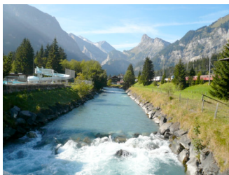
2 Kandersteg: Abschnittsweise fehlende Ufervegetation
