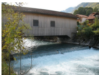
3 Sperre unterhalb der Rüdlenbrücke
