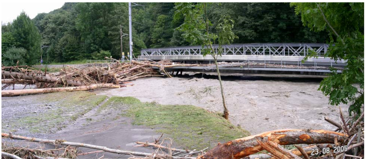
Abb 69 Teilverklausung der BOB-Brücke Gsteig durch Schwemmholz
