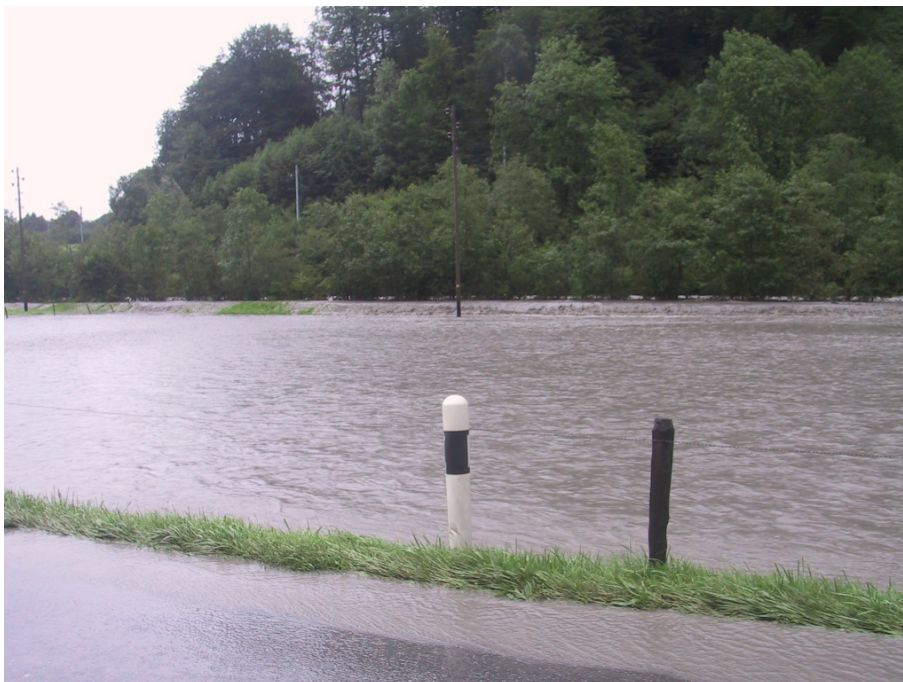
Abb 23 Praktisch vollständige Überströmung des Lüttschinentammes in der Tschingelmatta in Wilderswil. Aufnahme vom 22.08.2005, ca. 15.30 Uhr.
