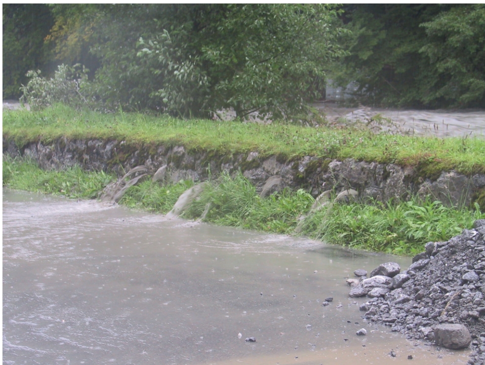
Abb 25 Ausflüsse aus dem Damm
