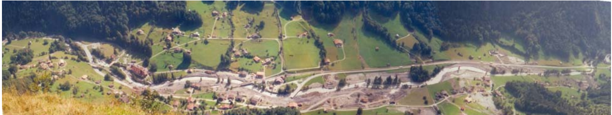
Abb 88 Gemeinde Lüttschental nach dem Hochwasserereignis
