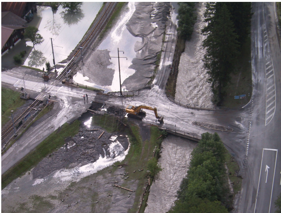
Abb 17 Entlastungsgraben durch Kantonsstrasse nach Grindelwald, Zweilüttschinnen.
