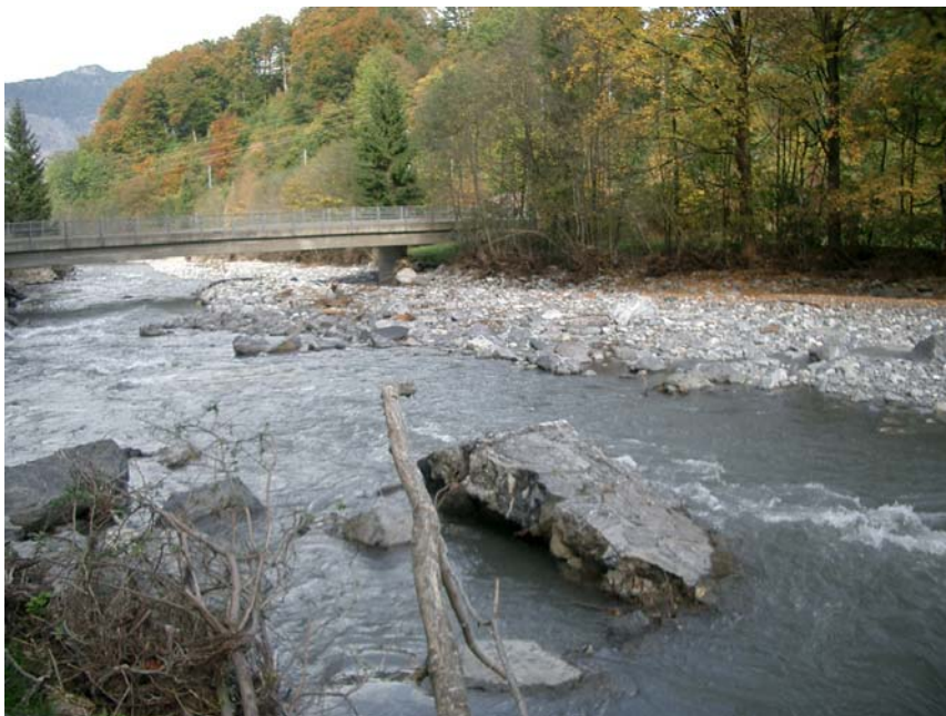
Abb 53 Ablagerungen im Bereich der Gsteigwilerbrücke
