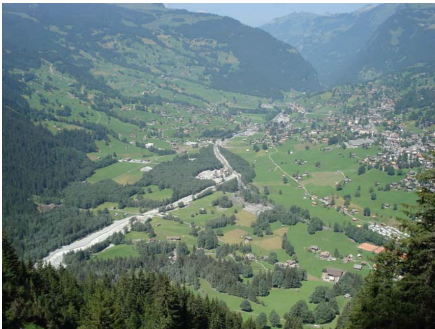
Abb 86 Übersicht Weisse und Schwarze Lütschine Grindelwald. Aufnahme vom 16.07.2006.
